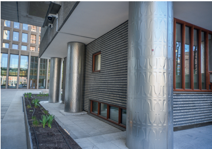
Høyblokka fra 50-tallet fremstår som ny etter gjenåpningen.
