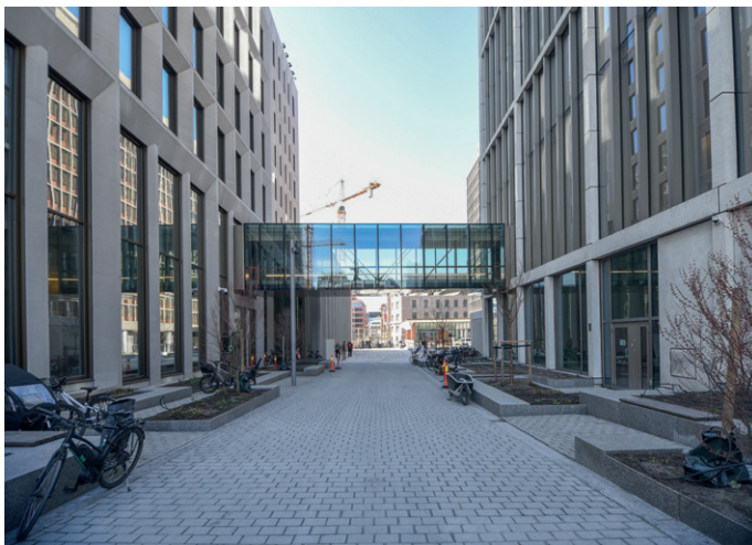
De tre bygningskroppene i første byggetrinn er forbundet med glass-bruer, her med A-blokka til høyre og D-blokka til venstre.
