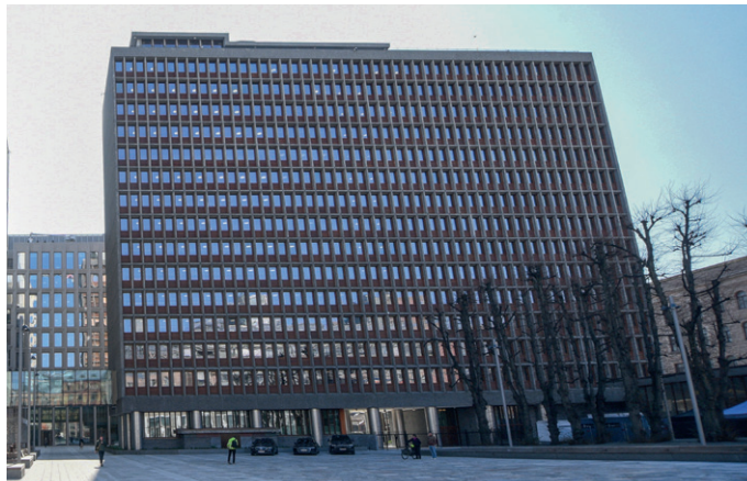
Fasaden mot Johan Nygaardsvolds plass og Akersgata er rehabilitert med gjenbrukt teak.
